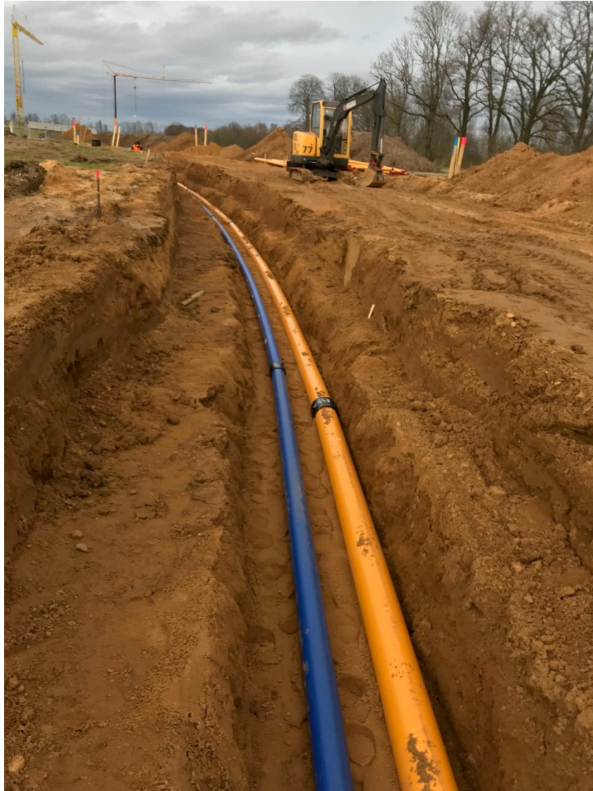
(Erschließung des Baugebietes „Hinter den Gärten“ (3. Bauabschnitt) in Titz; Januar 2020)
